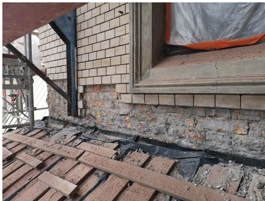
III Etap remontu zabrytkowej Cerkwi pw. Św. Jana Klimaka
